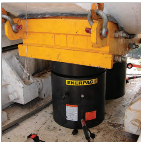
▲ Elevación pesada y nivelación de cimentación. La contratuerca de fijación permite la retención mecánica de la carga durante un largo período de tiempo.
