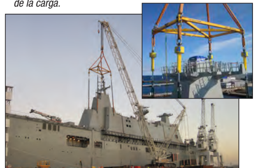
▼ Se usó un sistema SyncHoist para alinear bloques de acero de las secciones de la torre de control del buque para permitir la elevación y el posicionamiento graduales de la carga.
