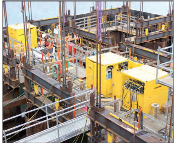
▲ Bomba hidráulica personalizada para un sistema de tendido de tablero de puente.
