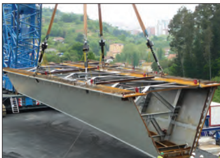
▼ Segmentos de puente levantados desde el terreno, y colocados en su lugar con un sistema SyncHoist de 4 puntos con cilindros totalmente monitoreados.
