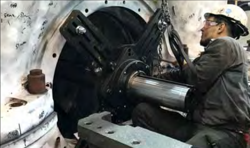
▲ Cortadoras de tubo y preparación de soldadura.
