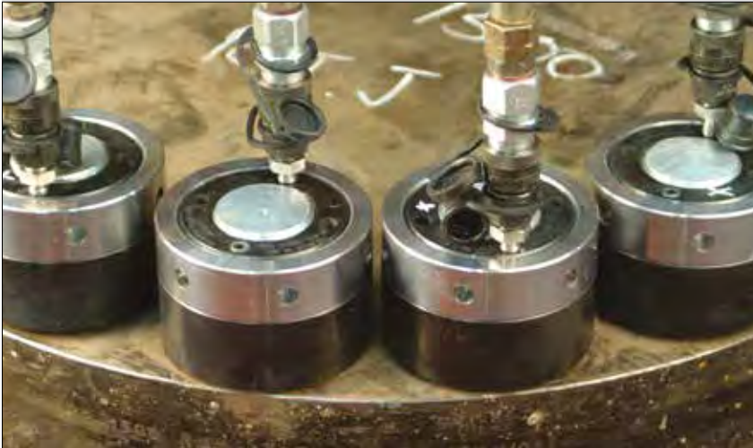
▲ Tensionado con tuercas hidráulicas.
