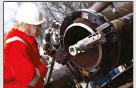
▲ Cortadoras de tubo y preparación de soldadura.
